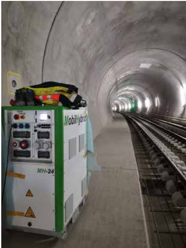
Erfolgreich im Einsatz der MH24 im Tunnel Jahrhundert Projekt Stuttgart 21.
